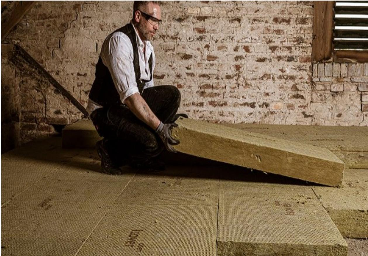
Die Dämmung der Kellerdecke, des Dachbodens oder des Steildaches ist aus energetischer und bauphysikalischer Sicht sinnvoll und aus denkmalpflegerischer Sicht gut möglich.
