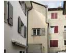
Une isolation en silicate de calcium est appliquée côté cour
