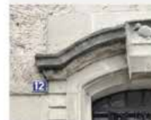
Les ornements et la porte d'entrée en bois sont préservés
