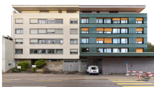
Mehrfamilienhaus Oberwilerstrasse Basel aus dem Jahre 1961
