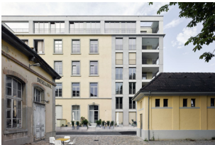
Kunz-Areal Windisch (AG): Transformation eines ehemaligen Spinnereiareals aus dem 19. Jh. in ein gemischt genutztes Areal
